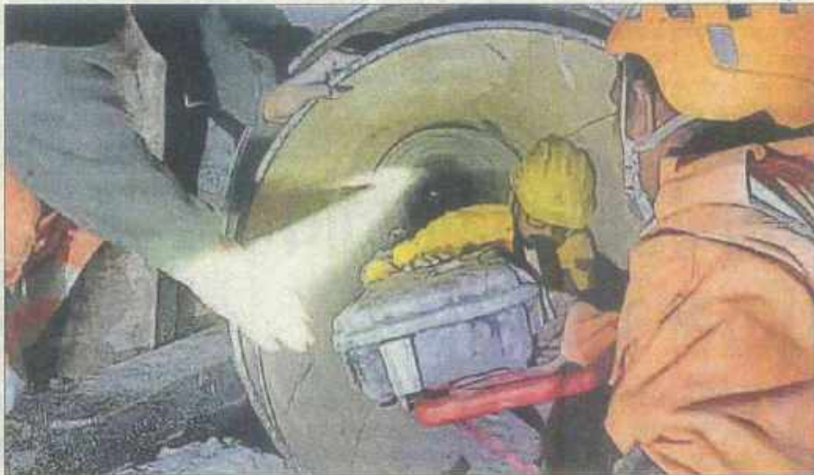
सिलक्यारा सुरंग में शुक्रवार को 800 एमएम पाइप के भीतर जाकर मलबे की जांच कर उपकरणों के साथ लौटते एक्सपर्ट। इसी उपकरण से पता किया गया कि मलबे में आगे का 5.4 मीटर का रास्ता साफ है। • हिन्दुस्तान
