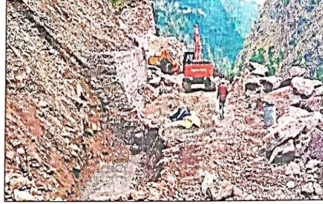
हेलंग बाईपास मार्ग के निर्माण में जुटी मरीना। संवाद
