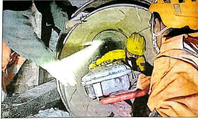
सिलक्यारा सुरंग में शुरुआत को 800 एमएम पाइप के भीतर जाकर मलबे की जाँच कर उपकरणों के साथ लौटते एक्सपर्ट। इसी उपकरण से पता किया गया कि मलबे में आगे का 5.4 मीटर का रास्ता साफ है। • हिन्दुस्तान
